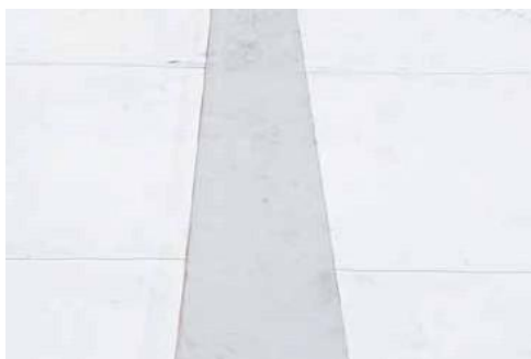
Pasek TPO nakładany na większą odległość
