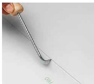
Kontrola zgrzewu za pomocą testera połączeń
